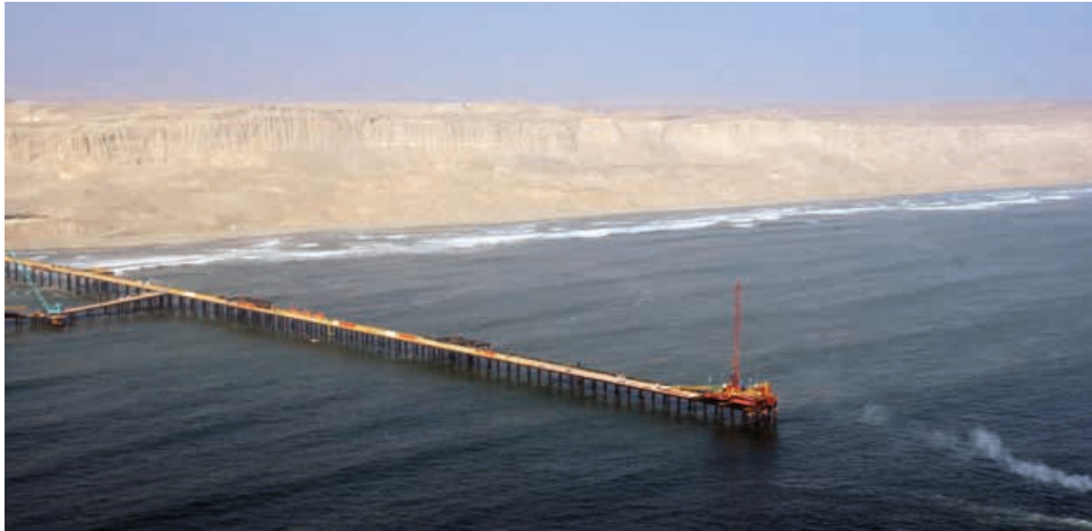
Terminal marina de la planta de licuefacción de Peru LNG, en la que Repsol controla un 20%
