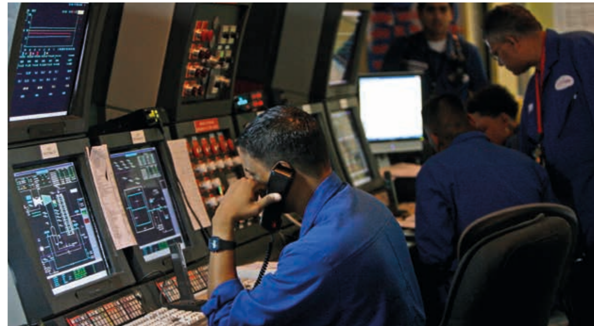
Sala de control en las operaciones de Trinidad y Tobago
