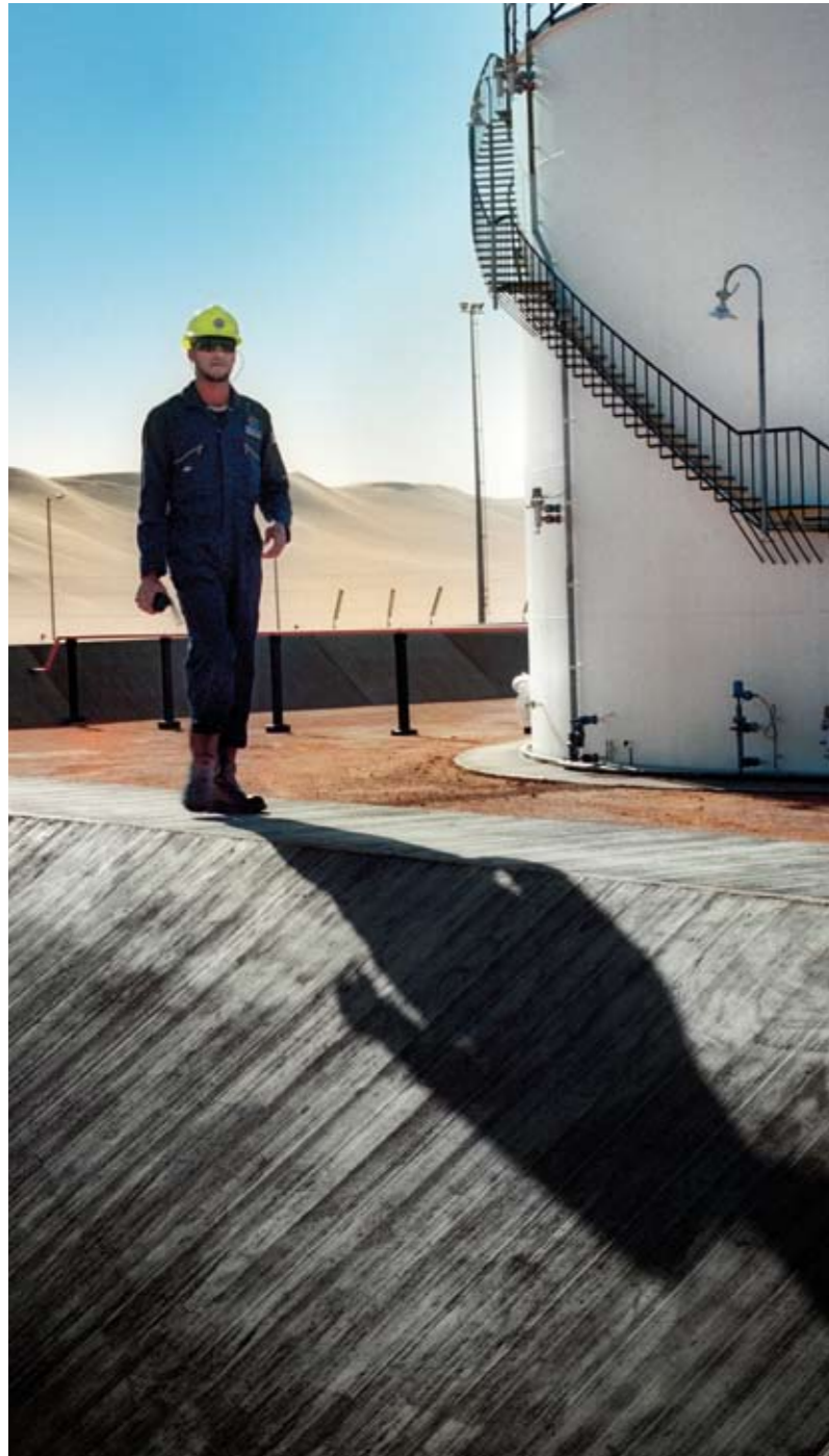
Instalación de Repsol en Libia.
