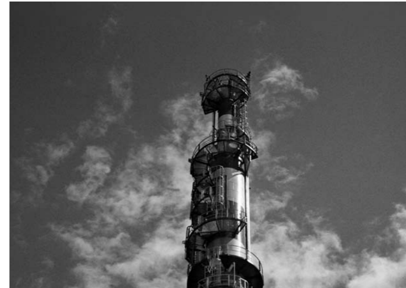
Torre de destilación de la refinería de Tarragona (España).
