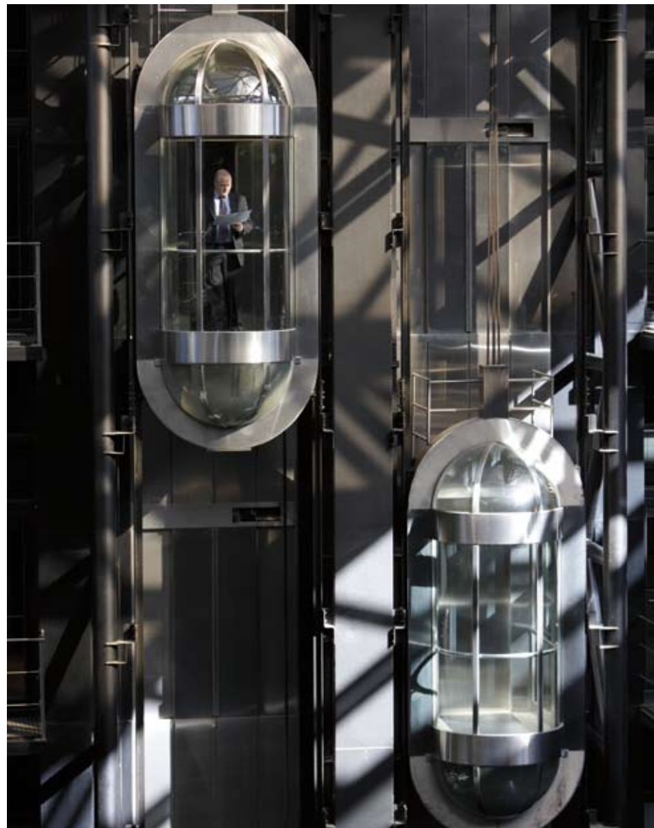
Ascensores de la sede central de la compañía en Madrid (España).
