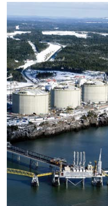
Planta de regasificación Canaport LNG (Canadá).
